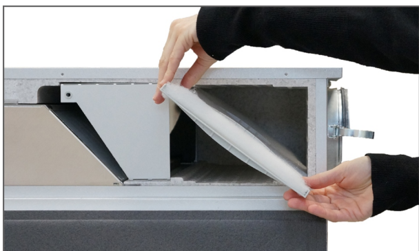
3. Filteret tages ud af aggregatet
